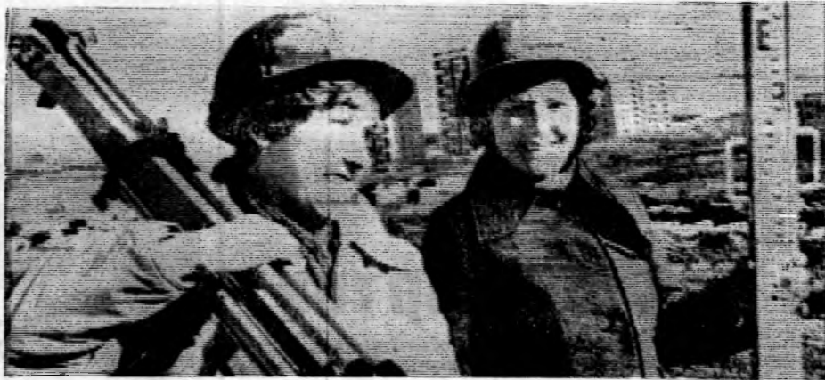
Строительство любого дома начинается с разбивки площадки. Умело, точно выполняют эту работу геодезист Г. Матвеева и рабочая А. Хорошилова из УС «Волгодонскэнергострой». Фото В. Яшина.
