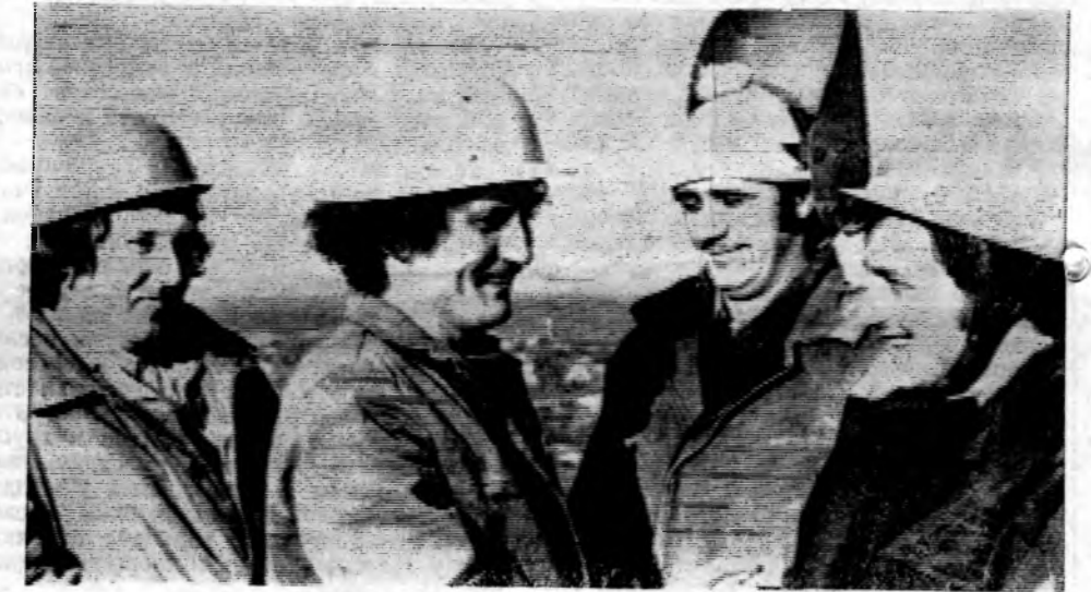
Широко известен на нашей стройке коллегтив, который возглавляет Павел Александрович Мазур из СМУ-1 управления «Волгодонэнергожилстрой». Рабочие этой бригады подняли над городом десятки новых этажей благоустроенных квартир. На снимке нашего фотокорреспондента вы видите представителей лучшего звена производственного коллектива (слева направо): С. ЛЕВЧЕНКО, А. МАРЫШЕВ, М. ПЛАСУН, Е. НЕСТЕРОВ (звеньева). Фото В. Комиссарова.
