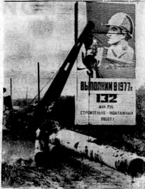
Идет монтаж водопровода к первому корпусу. Его ведет передовая бригада трубукладчиков из ССМУ-1 УСМР А. Данилова.
