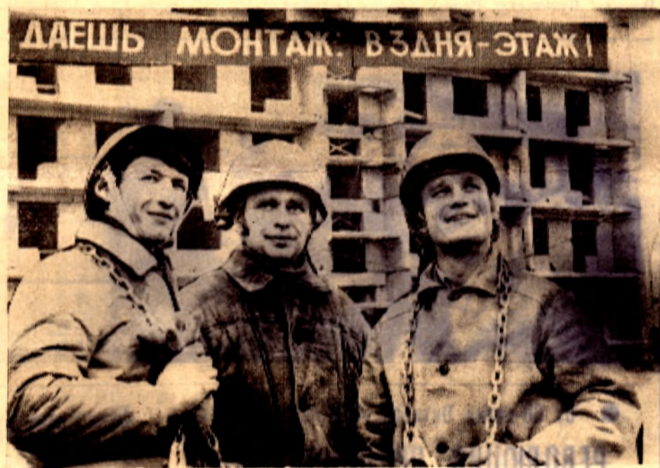
Звено В. Загуляева из бригады А. Удалкина (СМУ-2 «Волгодонскэнергострой») на монтаже 14-этажного дома строго придерживается графика: «Даешь монтаж в три дня — этаж!».
