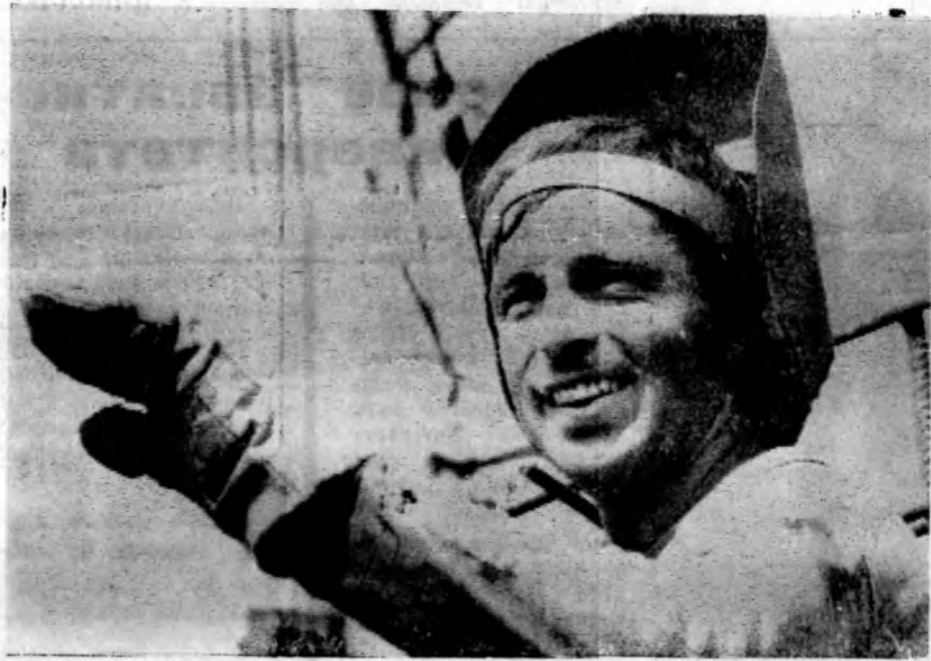
Виктор Патцель — один из лучших сварщиков бригады Г. А. Крыштанова из СМУ-12 УС «Заводстрой».
