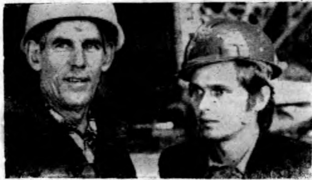
На снимке: начальник участка А. ЕФРЕМОВ и прораб А. ТОВКАЧ из СМУ-9 «Заводстрой», которые много уделяют внимания улучшению организации труда.
