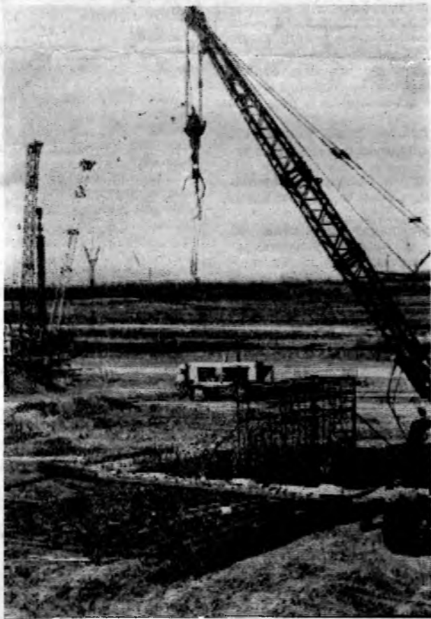
Главный корпус два года назад.
