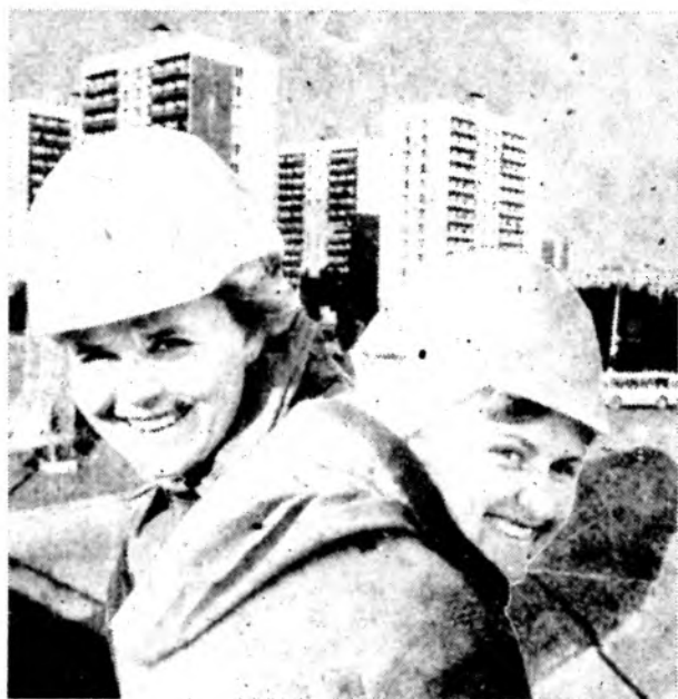
С энтузиазмом работают на строительстве дома № 263 члены МЖК-7 Светлана Жукова и Ирина Шинтай. Здесь, в бригаде Сергея Кудинова из СМУ-11 «Гражданстроя», они обрели навыки нескольких строительных специальностей.
