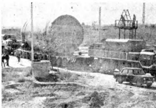
В октябре из ворот Атоммаша вышел очередной груз для Горьковской АЭС. На снимке В. ЧАЛЮБА вы видите момент перевозки части корпуса реактора АСТ-500 весом 180 тонн. Везут его на спецпричал работники «Спецтяжавтотранса».
