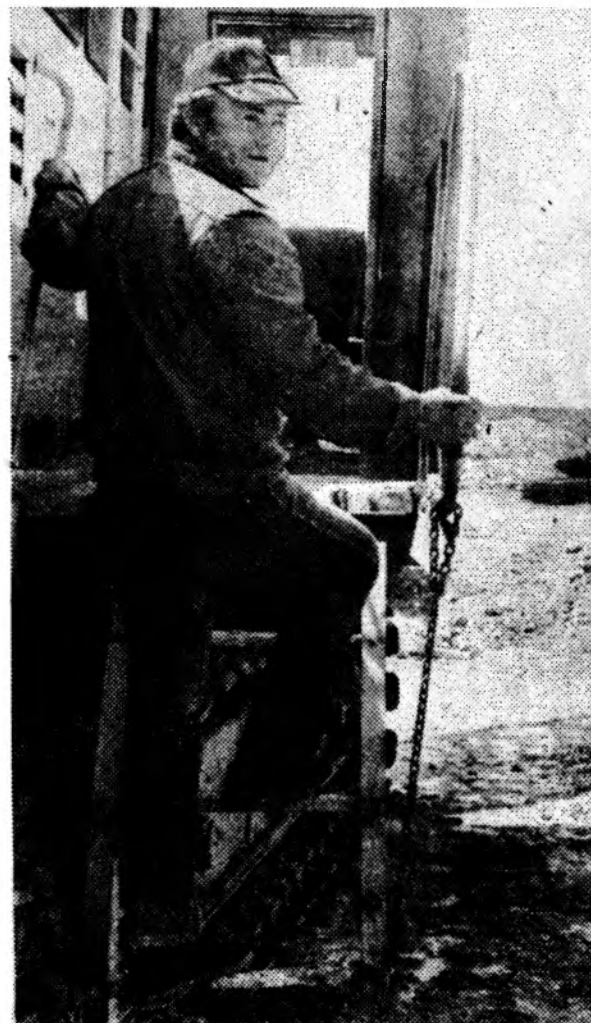
Активно участвует в реконструкции старых цехов и строительстве новых на заводе железобетонных конструкций машинист дизель-электрического крана Н. Сагеев (на снимке).
