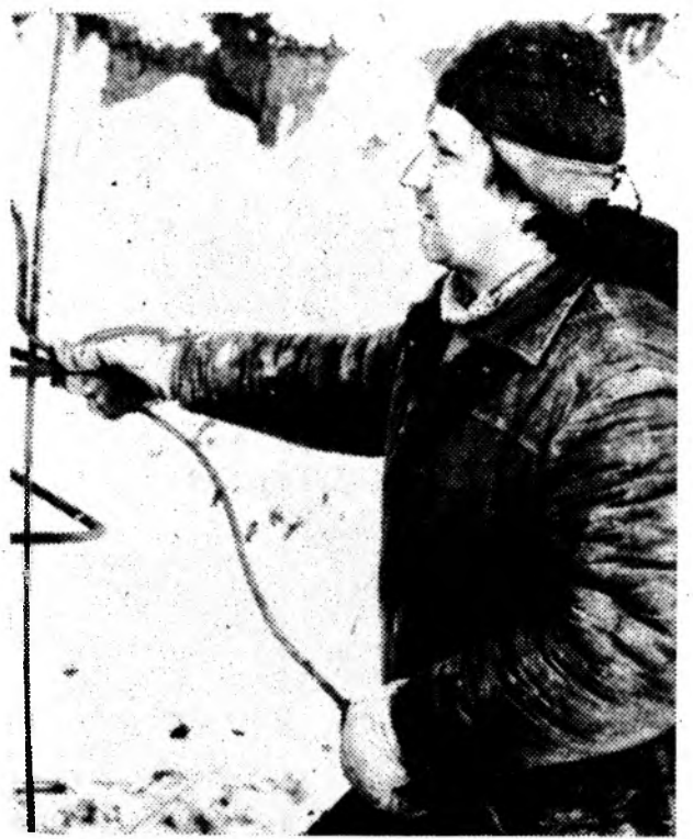
Сварщика СМУ-16 «Заводстрой» Николай Леонидович Каминского хорошо знают на стройке. Здесь он двенадцатый год. И все время сооружал объекты Атоммаша. Сейчас Николай Леонидович трудится на строительстве троллейбусного депо. Коммунист Каминский активно участвует в общественной жизни коллектива, является членом хозяйственного совета «Волгодонскстрой».
