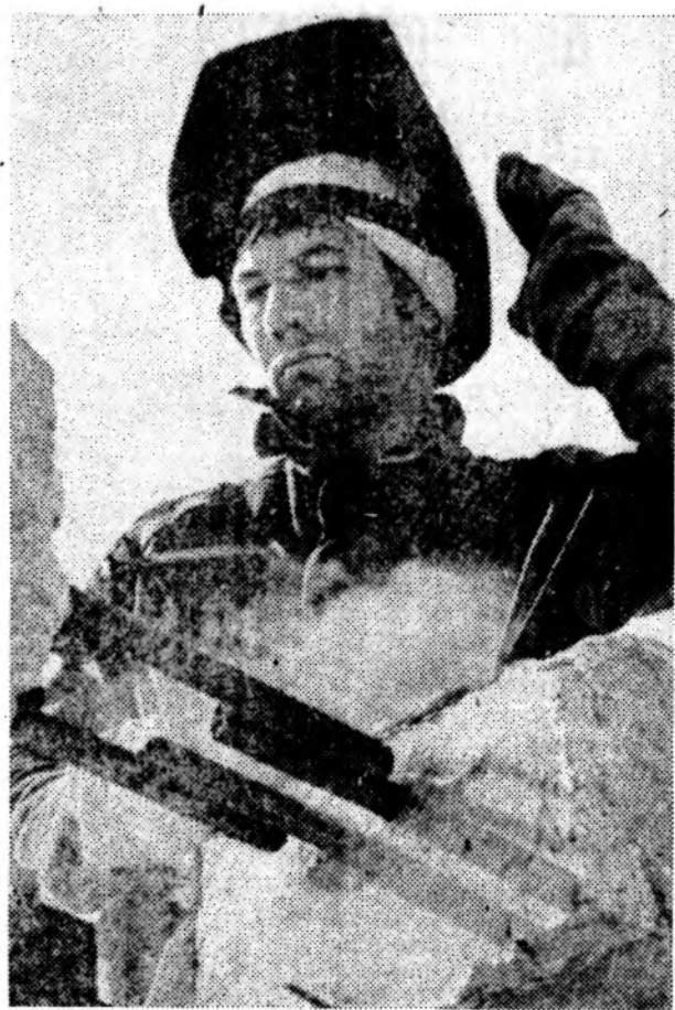
Ударно трудится на строительстве детского сада № 410 в квартале В-У плотник-бетонщик А. П. Ковтарев из СМУ-11 «Гражданстрой».
