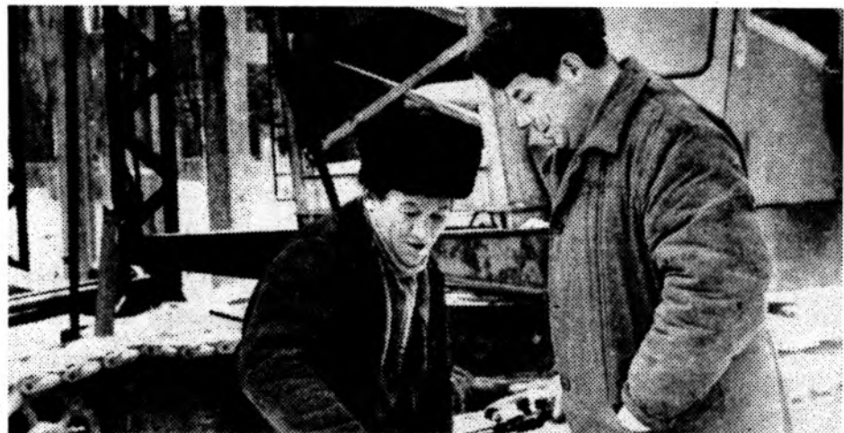
Ударно трудится на монтаже ректификационной установки на химзаводе им. 50-летия ВЛКСМ бригада М. П. Кремнева из «Юж- техмонтажа».
