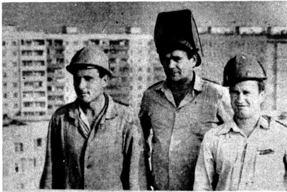
Коллектив монтажников СМУ-1 домостроительного комбината успешно справляется с заданиями по строительству жилья. Высокий показатель в труде добиваются
