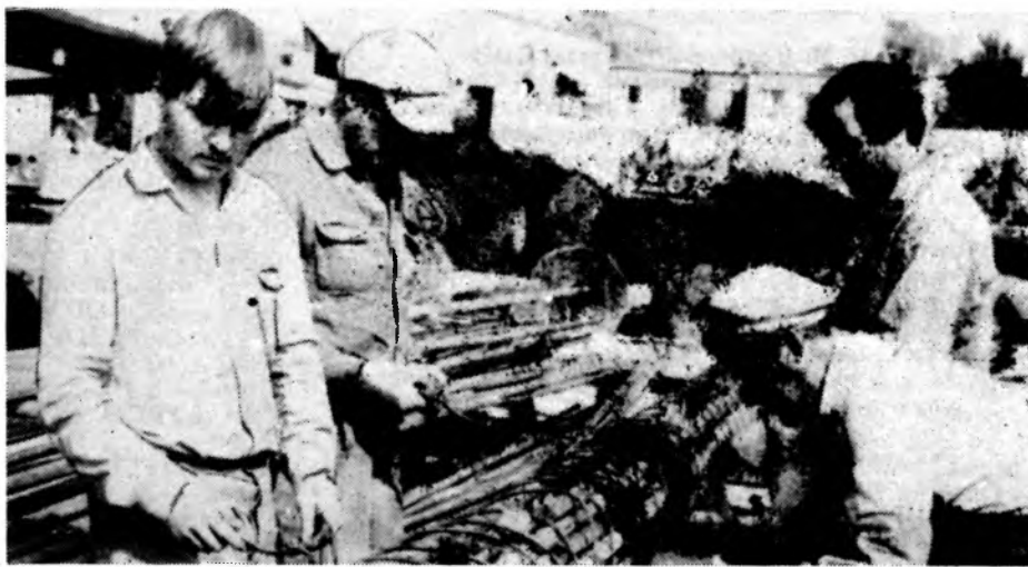
Бригада сварщиков-арматурщиков «Гидроспецстроя», которую возглавляет опытный бригадир Е. Янин, постоянно в числе лучших коллективов управления. Она делает каркасы буронабивных свай. Коллектив отличается высокой трудовой дисциплиной, большое
