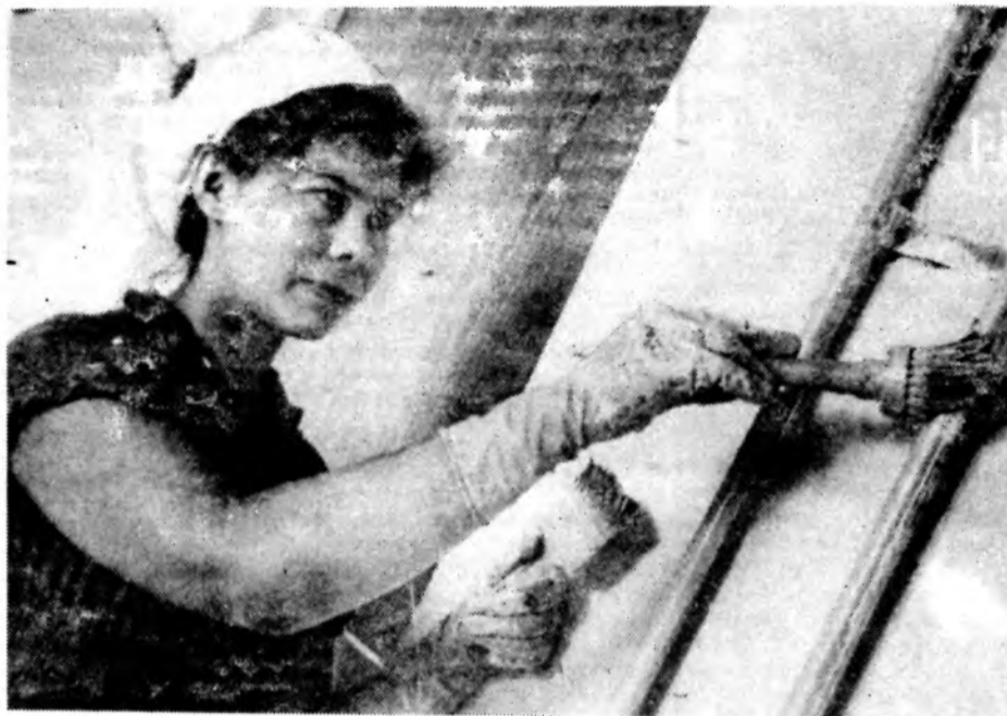
Неоднократно называлась в числе лучших работниц штукатур-маляр Светлана Иванова. Она трудится в бригаде М. Сазоновой из «Отделстрой», возводя гараж на 400 автобусов. Фото В. ЧАЛОВА.
