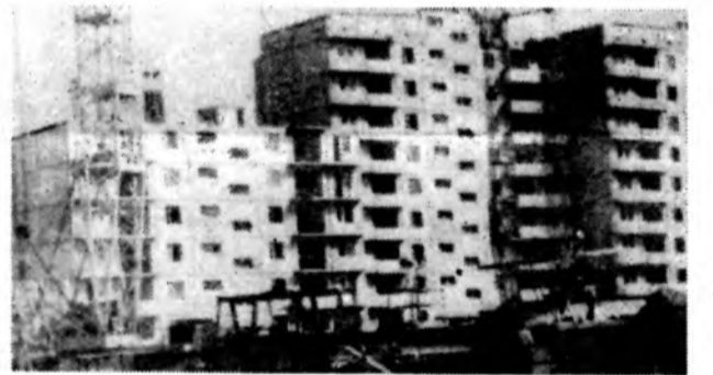
Строится жилье в квартале В-О. Фото А. ТИХОНОВА.
