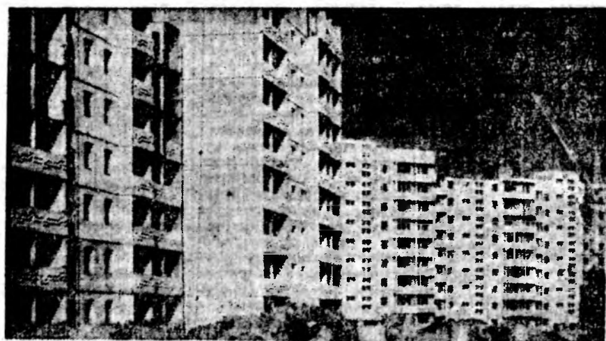
Волгодонск строится. В недалеком будущем эти дома заселят новоселы. Фото В. Арефьева.
