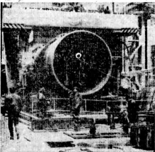
Цех корпусов парогенераторов. Идет сварка обода корпуса парогенератора.
