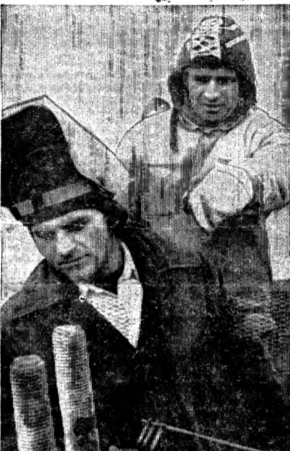
На снимке: сварщик В. Степаненко и плотник-бетонщик Ш. Сенгатулин трудятся на сооружении фундаментов корпуса № 5 «Атоммаша». В бригаде Спиридонова из СМУ-16 «Заводстрой» их уважают за добросовестный труд. Они неоднократно назывались в числе лучших в ходе социалистического соревнования.
