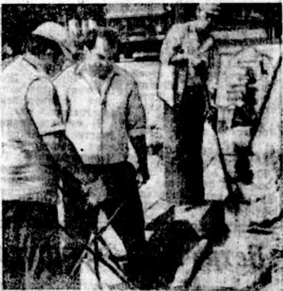
▲ С НЕВЫПОЛНЕНИЕМ ЗАДАНИЯ ИДЕТ РЕМОНТНЫЕ РАБОТЫ ПО УЛИЦЕ М. ГОРЬКОГО БРИГАДА И. ГЛУШЕНКО ИЗ ДОРОЖНО-РЕМОНТНОГО СТРОИТЕЛЬСТВА ГОРРЕМСТРОИТРЕСТА. ТОН В РАБОТЕ ЗАДАЮТ ОПЫТНЫЕ РАБОЧНИЕ, ТАКЖЕ КАК: В. СТУЛЬНИКОВ, И. КОНЫ, В. ЛЕВЧЕНКО. НА СНИМКЕ: РЕМОНТНИКИ БРИГАДЫ ВЕДУТ ЗАМЕНУ БОРДЮРНОГО КАМНЯ ПРОСЕКЕЙ ЧАСТИ УЛИЦЫ.
