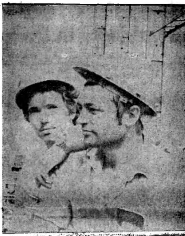
ОТЛИЧНО ТРУДИТСЯ НА УКЛАДКЕ БЕТОНА ПОД ОБОРУДОВАНИЕ НА МАШИНОМ ЗАЛЕ РЕАКТОРНОГО ОТДЕЛЕНИЯ БЛОКА № 1 РОСТОВСКОЙ АЭС ЗВЕНО, ВОЗГЛАВЛЯЕМОЕ В. ВОРОНИНЫМ ИЗ СМУ-6 «АТОМ ЭНЕРГОСТРОЙ».
