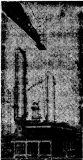
На Томском химическом заводе заканчивается сооружение установки по производству метанола мощностью 750 тысяч тонн в год. С ее пуском предприятие будет давать около трети всего выпускаемого в стране ценного химического сырья, необходимого для получения смол, волокон, пластических масс.
