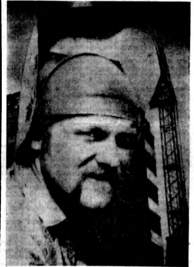
Ударно трудится на строительстве жилья сварщик бригады А. Туганова из СМУ-3 ДСК Виктор БОРИСОВ (на снимке).
