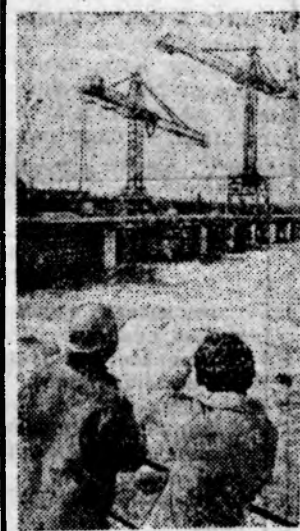
Чувашская АССР. Полным ходом идут работы на строительстве Чебоксарской ГЭС.
