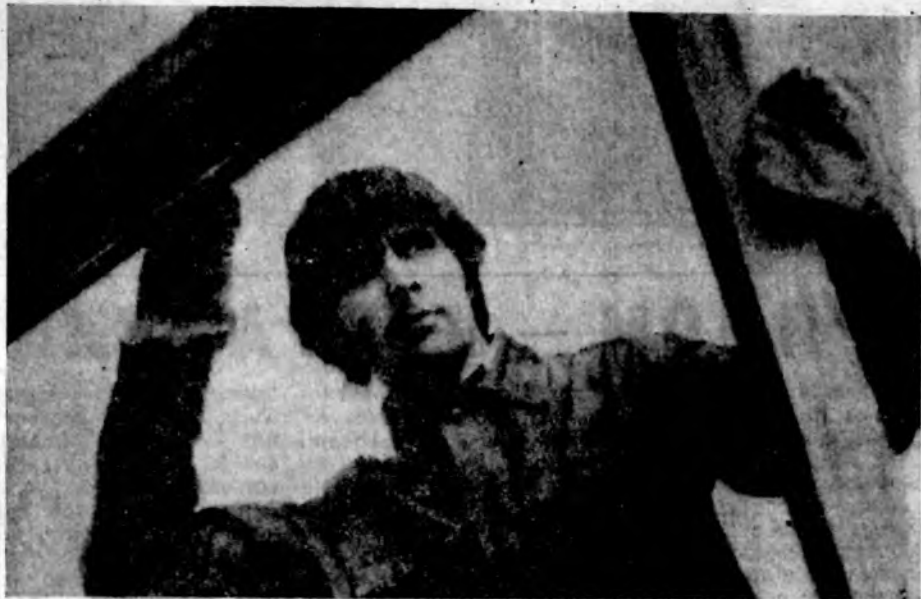
Коллектив бригады Н. Колесникова из монтажного управления треста «Волгодонскэнергострой» ведет установку маршей и других узлов на второй очереди первого
