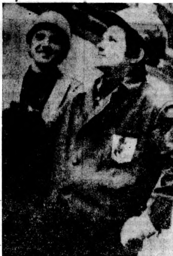
Монтажники Волгодонского участка Ростовского монтажного управления № 2 Николай РУДКОВСКИЙ и Вячеслав ГОЛУБОВ (на снимке) монтируют мостовые краны в корпусах «Атоммаша». С их участием уже смонтировано более двенадцати кранов. Коллектив бригады, в которой они трудятся (бригадир Р. Минх), стремится удерживать высокие темпы, достигнутые в дни работы XXVI съезда КПСС.
