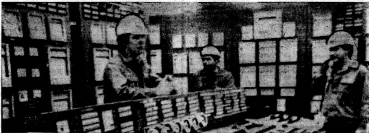
Отлично справляется с работой смены котло-турбинного цеха Волгодонской ТЭЦ-2, которую возглавляет Ю. Н. Мастиков. На снимке: машинист блока
