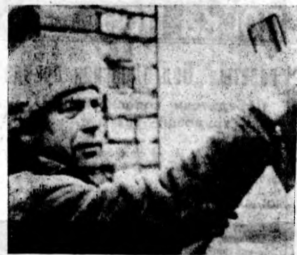
Л. Л. ТРОХИН (на снимке) работает последние три года в нашем городе. Сейчас он трудится на возведении самостроевского дома ЮТМ, ежемесячно перевыполняя задания. Фото А. Тихонова.
