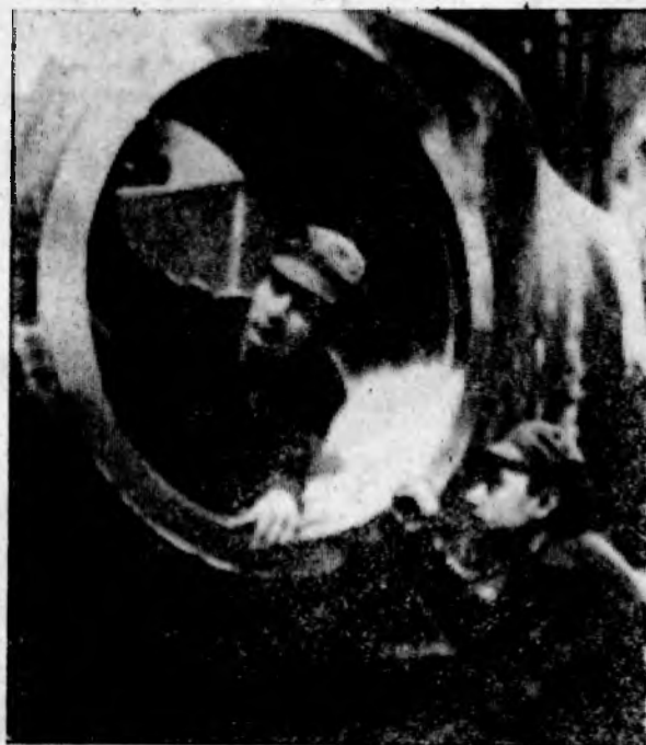
В. К. Прянин (справа) и Звездовой, наставник В. Н. Бузиненко трудятся в бригаде В. Логвиненко из ЦКО «Атоммаша». Они ведут ручную зачистку антикоррозийной поверхности блока корпуса реактора. С работой справляются успешно.
