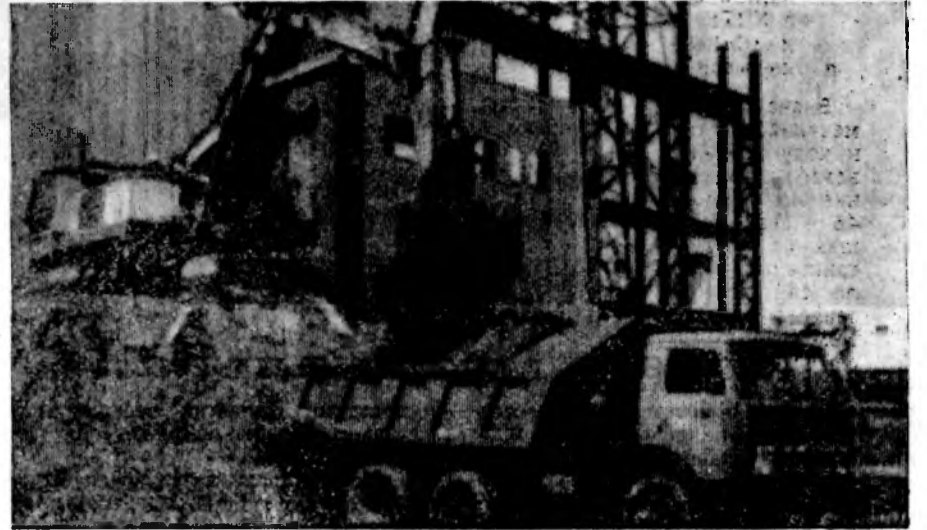
Полным ходом идет благоустройство территории, прилегающей ко второму корпусу завода «Атоммаш» (на снимке).
