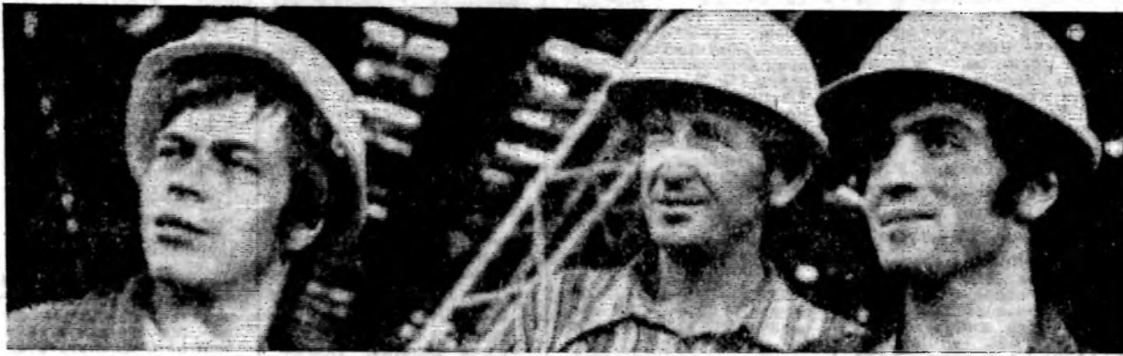
Коллектив СМУ-9 «Заводстрой» бетонирует фундаменты под оборудование в корпусе № 4. Хорошо справляется с работой звено, возглавляемое коммунистом Н. П. Пономаревым.
