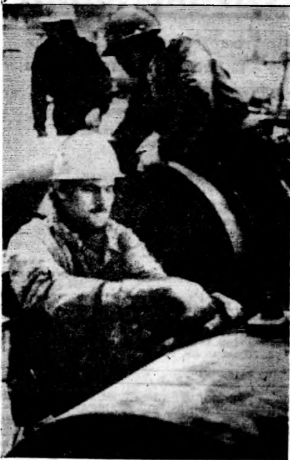
Ростовское монтажное управление № 2 ЮТМ ведет монтаж мостовых кранов. Бригадой В. Крымова только на второй очереди установлено около 20 кранов. Александр Васильевич ПОЛЯНСКИЙ (на снимке на первом плане) приехал сюда в 1976 году. Это с его участием был установлен на «Атоммаше» первый кран.
