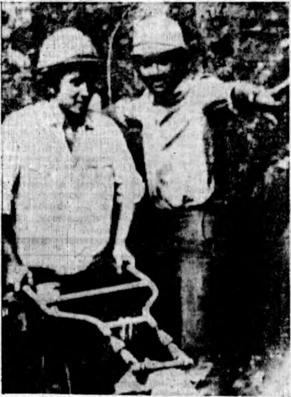
Плотники бетонщики Н. Г. Меньшиков и А. Г. Морозов из СМУ-8 «Промстрой-1» работают в бригаде имени XXV съезда КПСС. Сейчас бригада, которую возглавляет коммунист С. Е. Меркулов, ударно трудится на устройстве полов и фундаментов под оборудование на главном корпусе второй очереди ДСК-280. На снимке: Н. Г. МЕНЬШИКОВ и А. Г. МОРОЗОВ за работой. Фото А. Тихонова.
