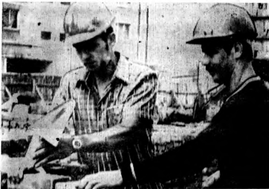
Второй год работают в бригаде каменщиков, возглавляемой В. Ф. Киченком из СУ-31, М. А. СТРОГАНОВ и В. А. ВЕРЧЕНКО (на снимке). Быстрота и слаженность в работе позволяют им добиваться высоких результатов. Занятые на кладке стен второй очереди жилого дома № 7, они постоянно перевыполняют сменные задания. Фото А. Тихонова.
