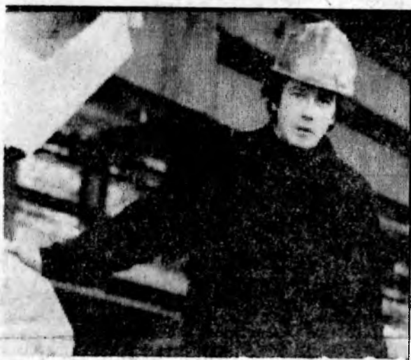
Ударно трудится на корпусе № 6 в дни 100-суточной вахты звеньевой бригады плотников-бетонщиков второго участка СМУ-9 «Заводстроя» А. В. Пищаскин, ежедневно перевыполняя задания.
