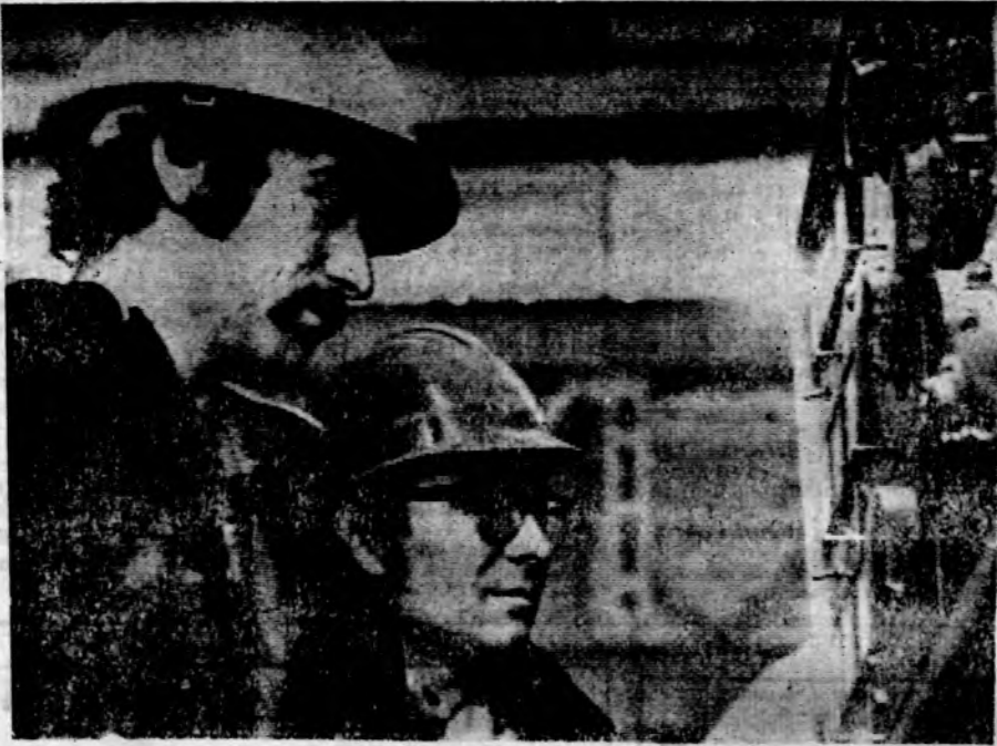
Бригаде электриков цеха корпусного оборудования «Атоммаша», которую возглавляет коммунист М. Г. Михельсон, много пришлось потрудиться на монтаже и наладке оборудования. Силами бригады отлажено электрооборудование на многих токарно-карусельных, фрезерных и других станках. На снимке: М. Г. МИХЕЛЬСОН и член бригады А. В. ТЮФЯКОВ.
