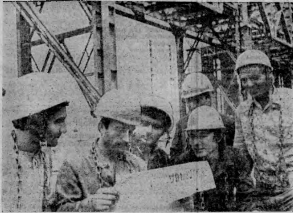
На главном корпусе Атоммаша бригада монтажников М. Н. Гуро из управления «Южстальконструкция» за обсуждением проекта Конституции СССР. Фото В. Яшина.
