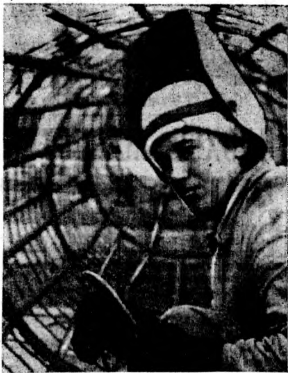
Комсомолец Андрей Светлышнев трудится электросварщиком на строительстве Волгодонского завода тяжелого машиностроения второй год. Сейчас он варит каркасы для свай под цехи завода. Задание, как правило, выполняет на 130—140 процентов. Избран профгруппоргом арматурного цеха.
