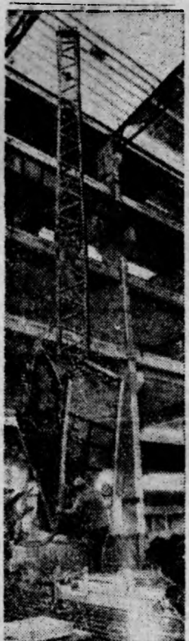
Три миллиона шестьсот тысяч киловатт — такова мощность одной из крупнейших новостроек пятилетки. Рязанской ГРЭС. Рядом с ГРЭС растет поселок Новомихуринск. На снимке: укладка бетона в основание пера турбогенератора. Тото А. Пушкарева (Фотохроника ТАСС)
