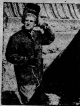
С первых дней работы на строительстве Днепротэ-2 электрогазосварщик, член КПСС В. А. Савченко. Передовик социалистического соревнования, работа на сварке труб, выполняет производственные задания на 120 процентов.
