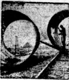
В юго-западной Болгарии сооружается мощный энергетический комплекс «Ббвс дол». Фото ВТА-ТАСС.
