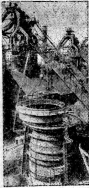
Челябинск. Рядом с действующей доменной печью № 1 на Челябинском металлургическом заводе идет монтаж новой печи. Эта домна будет почти в два раза мощнее старой, которая дала первый чугун в 1944 году и вот уже 28 лет находится в строю. Новая печь монтируется на колесах. Домну передвинут на нужное место с помощью лебедок. НА СНИМКЕ: ставится первый блок кожуха шахты доменной печи. Фото В. Клиппингера. (Фотохроника ТАСС).
