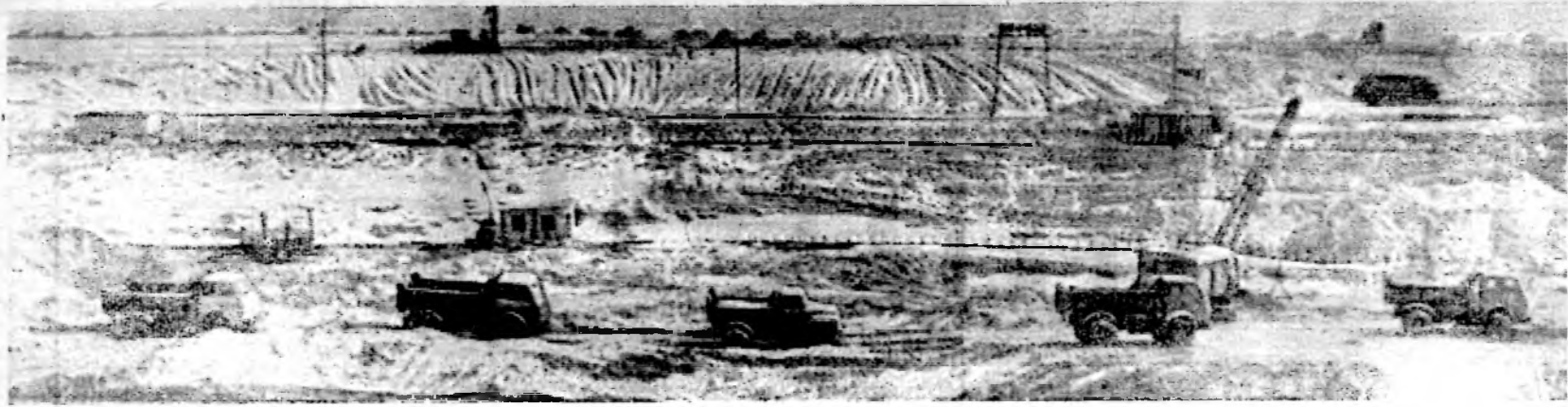
НА СНИМКАХ: ● Общий вид строительства котлована (снимок сверху). ● Строители гидроузла: бригадир скреперистов В. И. Золотухин и скреперист В. М. Родионов (на среднем снимке). ● Очередная летучка у А. Н. Тесля (первый слева) — начальника участка механизированных работ № 1 (снимок внизу). Фото А. Бурдюгова.
