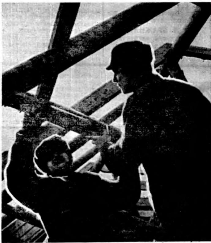
Плотники строительного управления № 31 В. В. Зюзин и Л. И. Ильин (на снимке) возводят стропила для кровли на жилом доме. Задания они перевыполняют систематически.
