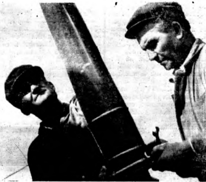
Наряду с другими работами, связанными с подготовкой к зиме, в колхозе «Ключ Ильича» на центральной усадьбе решили хорошо отремонтировать всю водопроводную систему. Вместо старых износившихся водопроводных колонок здесь будут установлены новые.
