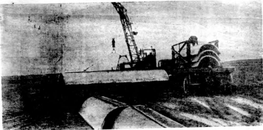
Совершенствуется оросительная система в мясном совхозе «Дубенцовский». Вместо грунтового канала, питающего хозяйственную оросительную сеть, здесь начали прокладку канала из железобетонных лотков. Он полностью сокращает потери воды на фильтрацию. Эта работа поручена бригаде из ПМК-7 «Волгодонскводстрой», возглавляемой Р. Т. Ткаленко. К началу влагозарядковых поливов монтажники установят лотки на протяжении 4200 метров.
