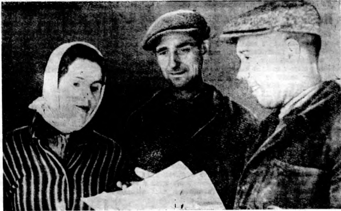
НА СПИМКЕ: бригадир бригады отличного качества П. Е. Трубачев, штукатуры М. Г. Токин и Е. М. Бобровская за подведением итогов работы за день. Вся работа, выполненная штукатурами бригады П. Т. Трубачева принимается с высокой оценкой.
