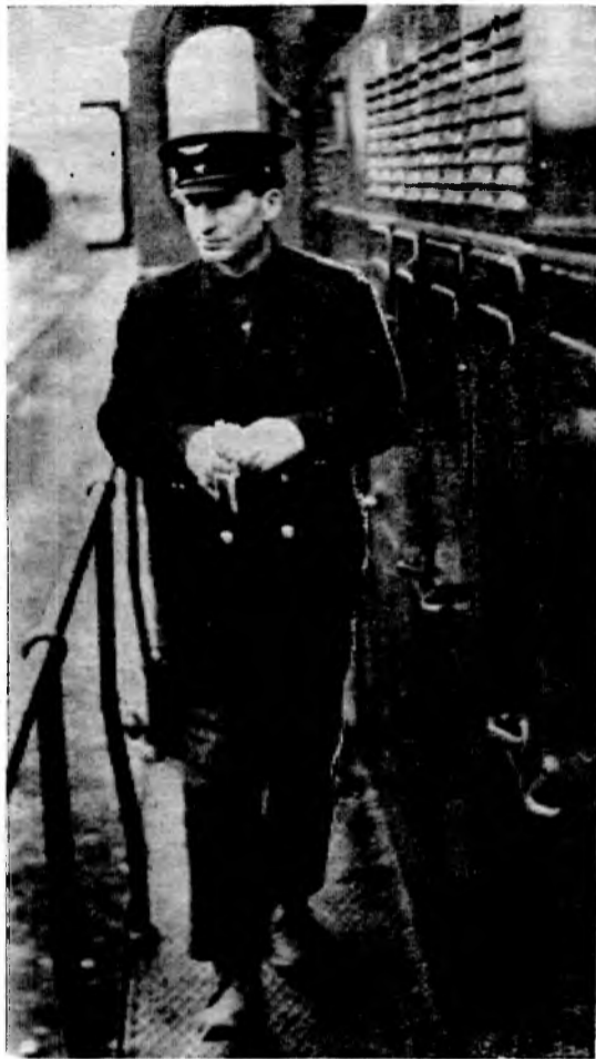
тором стенной газеты «Тепловозник».
