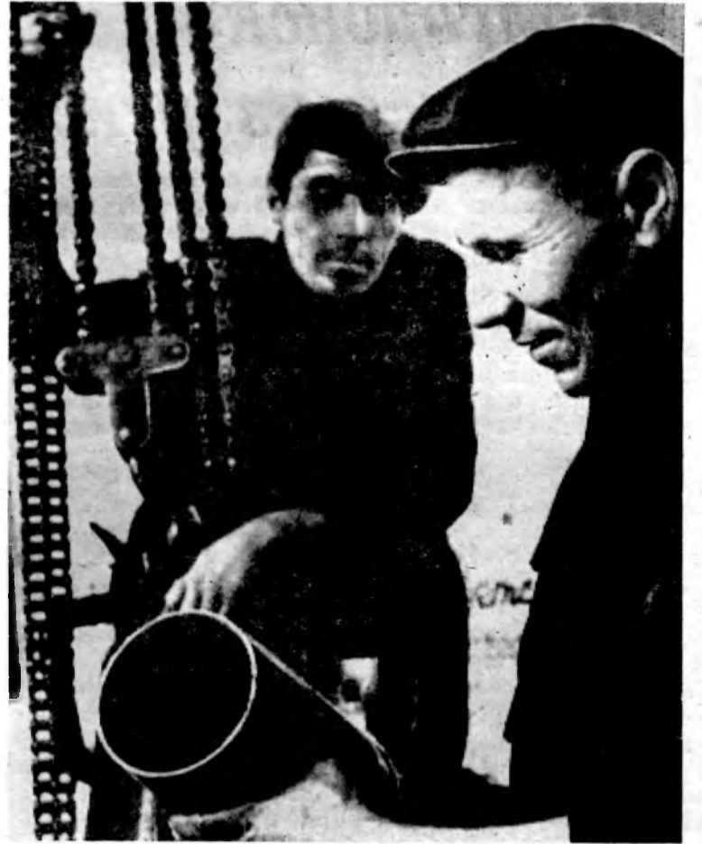
Мотор—сердце трактора. Вот почему в мастерской зерносовхоза «Добровольский» ремонт моторов поручен наиболее опытным слесарям. На ремонт двигателя отводится 96 часов, но Михаил Зиненко и Федор Савчук выполняют эту работу за 72—75 часов. Качество безупречное.
