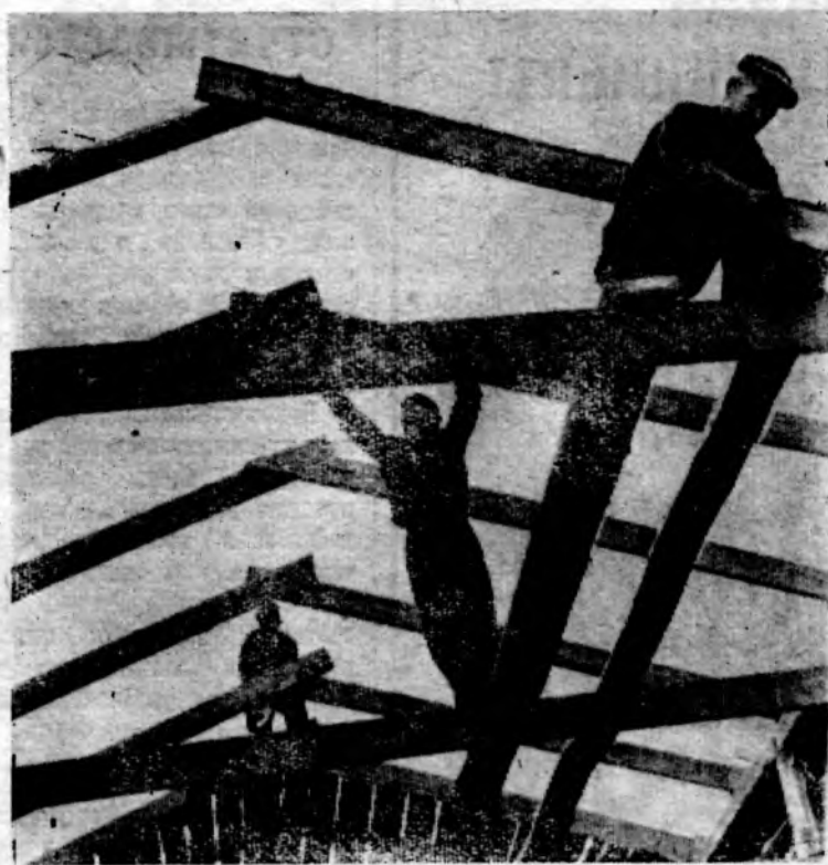
НА СНИМКЕ: в мясо-молочном совхозе «Дубенцовский» строится механизированный коровник на 200 голов.
