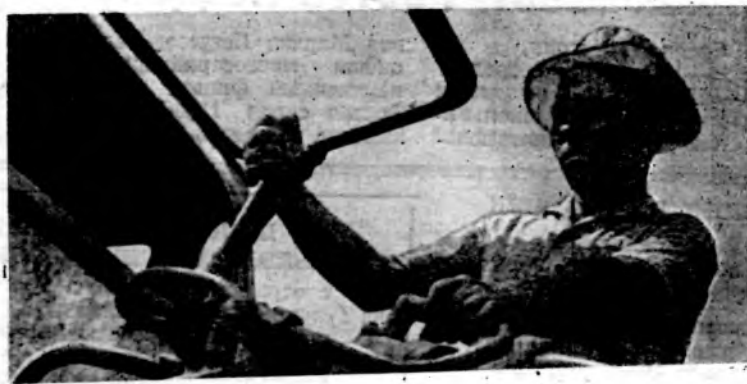
Машинист экскаватора зерносовхоза «Потаповский» Петр Карлович Петров ремонтирует оросительные каналы, роет траншей, ведет и другие работы.
